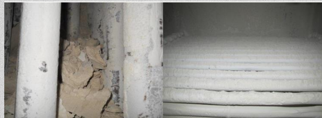
Рисунок 3 Шлакование поверхностей нагрева
